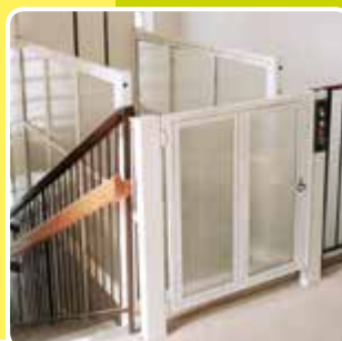
Čiastočné ohradenie hornej stanice
